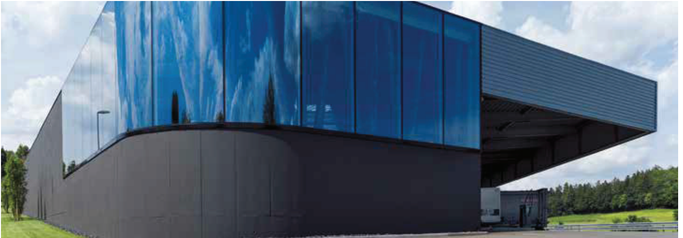
Der Lagerneubau schafft Platz für die Logistik des expandierenden Unternehmens und automatisiert alltägliche Lageraufgaben. Da der Grundriss ohne Stützen und Innenwände auskommt, lässt sich die Halle flexibel nutzen.
