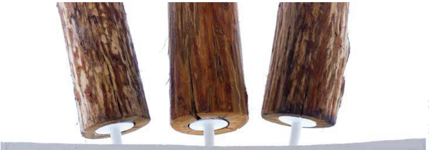
Die 25 cm dicken, fast roh belassenen Eichenstämme sitzen schräg eingebaut hinter dem Glasbereich der Fassade auf einer Betonwand. Sie verweisen gestalterisch auf das Material Holz als einen der Hauptwerkstoffe von ziefleko und sind Teil der architektonischen CI des Unternehmens.
