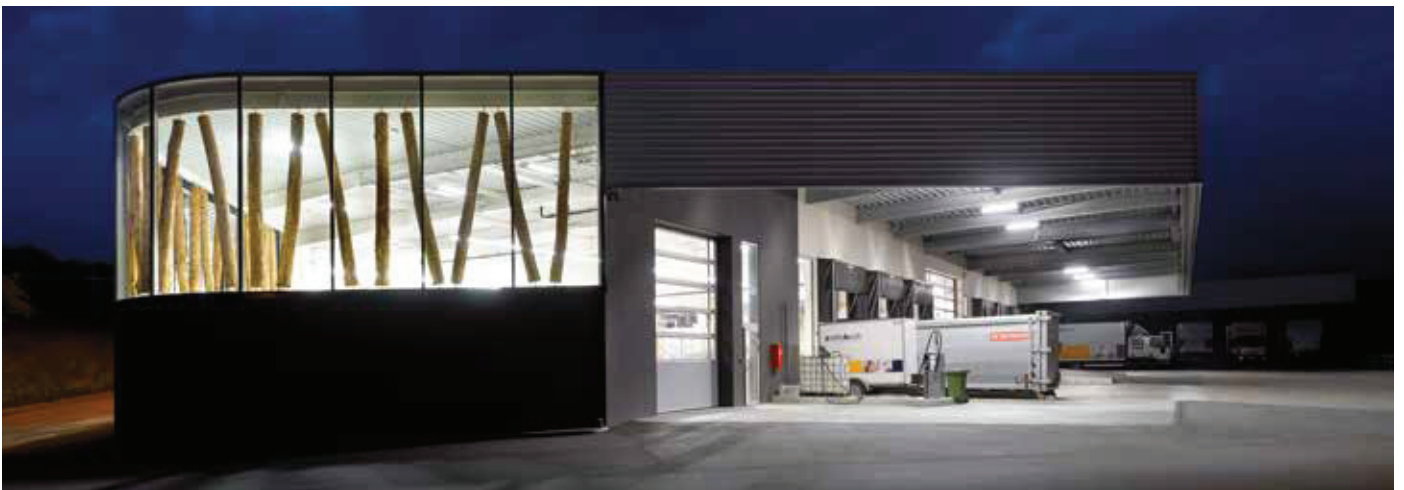
Über eine Rampe können Stapler und Lkw durch das 8 m breite Zentraltor in die Halle fahren. Zudem gibt es sechs Laderampen mit Überladebrücken. Ihre Anfahrt liegt auf Hofniveau. Die zugehörigen Sektionaltore trennen die Rampen thermisch komplett ab – be- und entladen wird also im Warmen.
